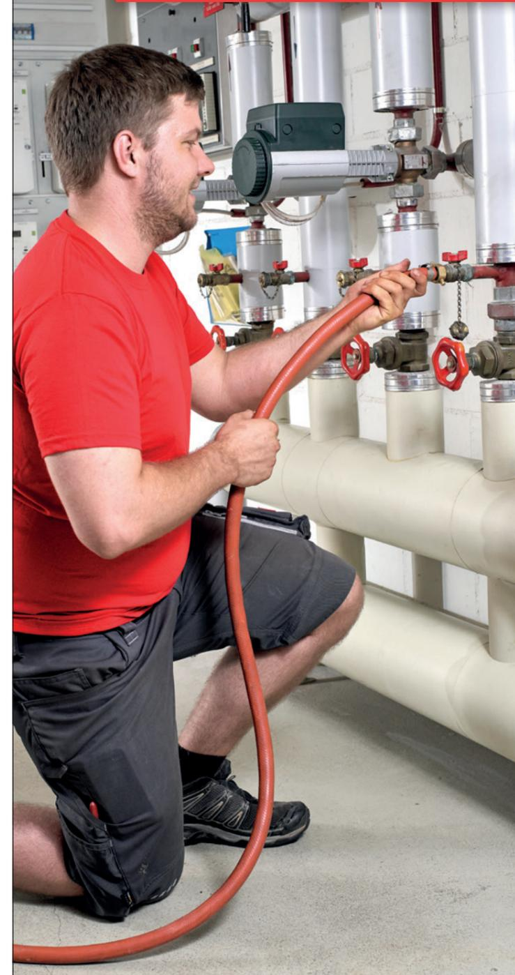
Erfüllt die Heizungswasserqualität nicht die Richtlinie SWKI BT 102-01, kann das zu folgenden Problemen führen (Schaden an Heizungskomponenten; Schadenersatzforderungen bei fehlenden Abnahmeprotokollen).
